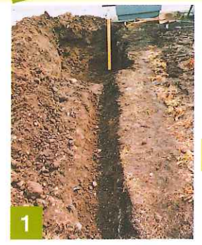
1 設置場所を決め、便槽とトレンチ設置部分の穴を掘ります。
