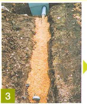
3 トレンチ部分に浸透材を入れ、埋め戻します。
