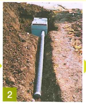
2 便槽とトレンチを水平に設置します。
